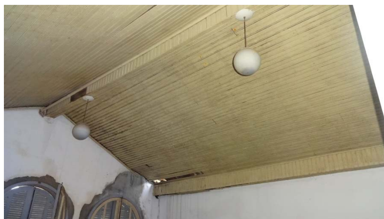
Fig. 5: Instalações elétricas passando pela cobertura.
