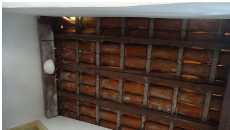
Fig.4: Fiação elétrica aparente passando pelo madeiramento da cobertura.
