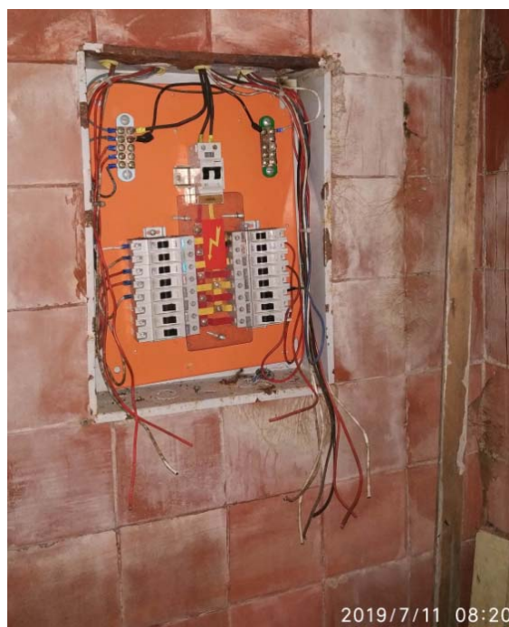
Fig. 3: Quadro de energia existente.
